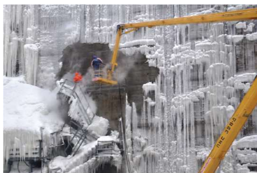
Рис.4. Ликвидация обледенения сооружений Саяно-Шушенской ГЭС с помощью горячей воды
