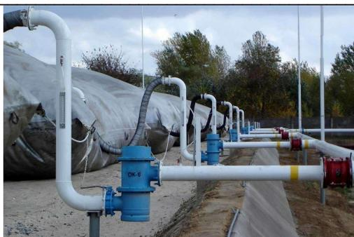
Рис. 6. Эластичные газокompенсаторы, подключенные к газовой обвязке подземных резервуаров
