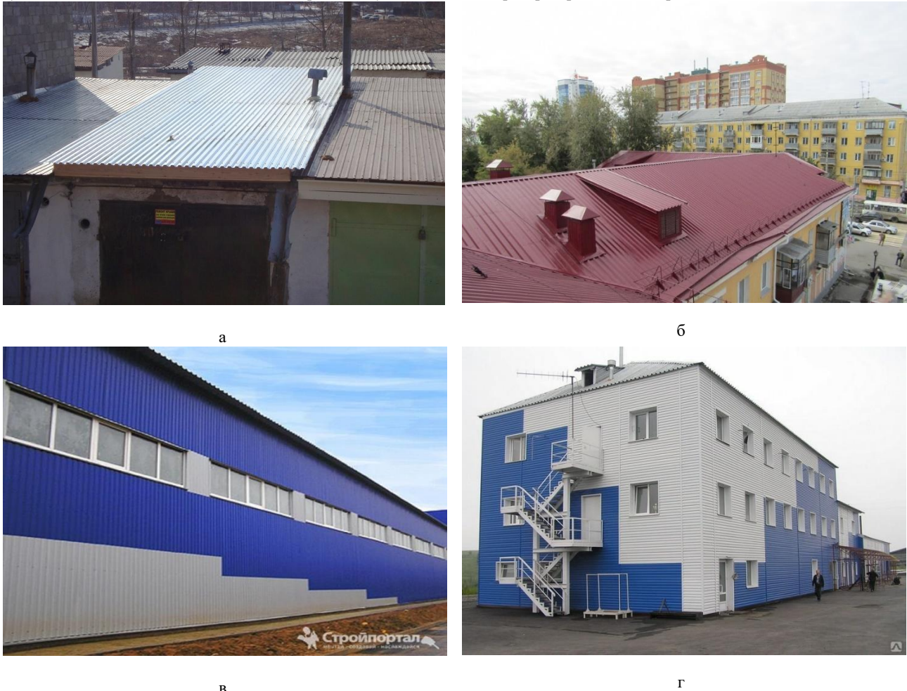
Рис. 1. Варианты применения рассматриваемых строительных материалов: а – крыши гаражей для стоянки транспортных средств; б – крыши многоквартирных жилых домов; в – фасады производственных зданий; г – фасады административно-бытовых зданий
